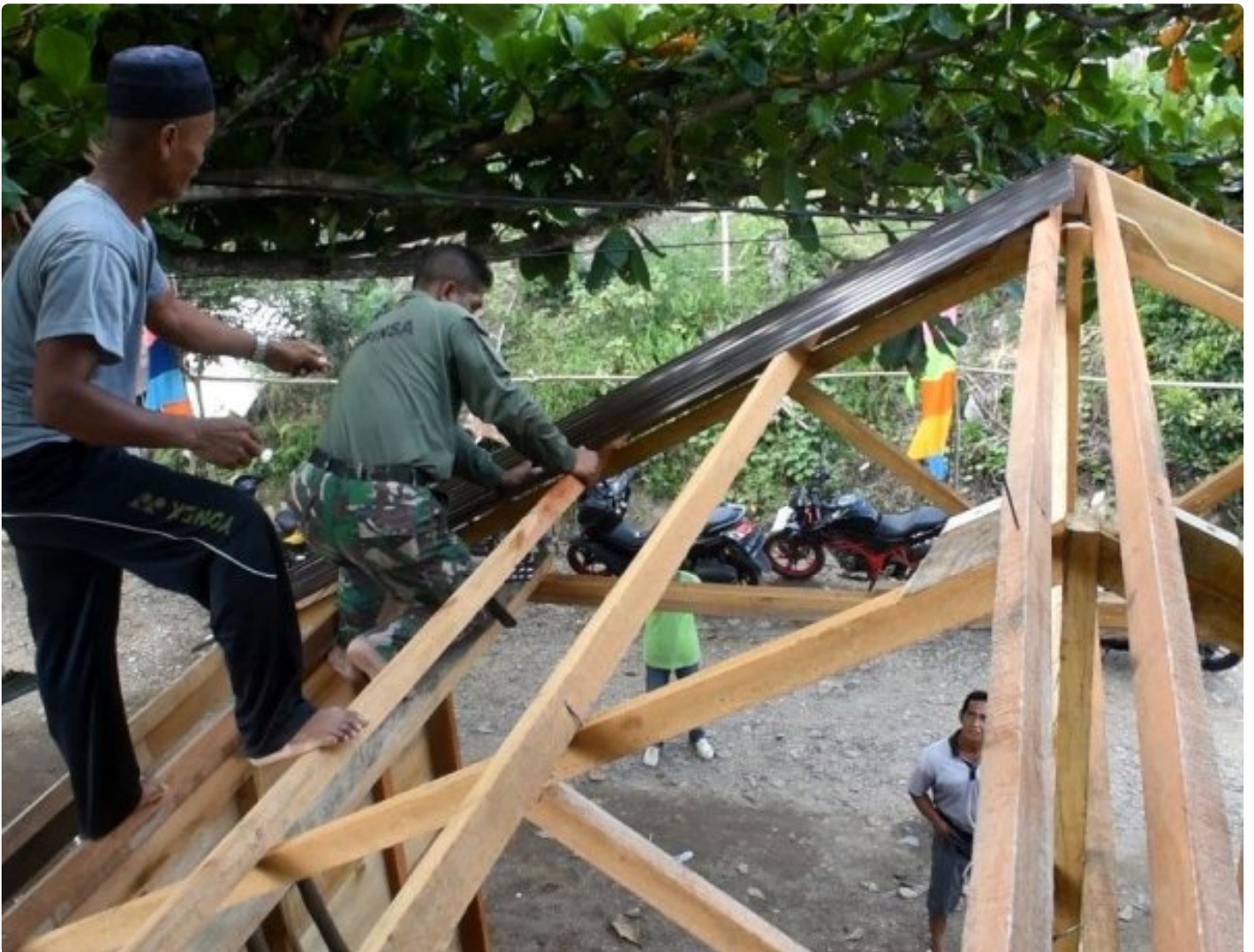
Sasaran Rehab Rumah Tidak Layak Huni Capai 30 Persen
