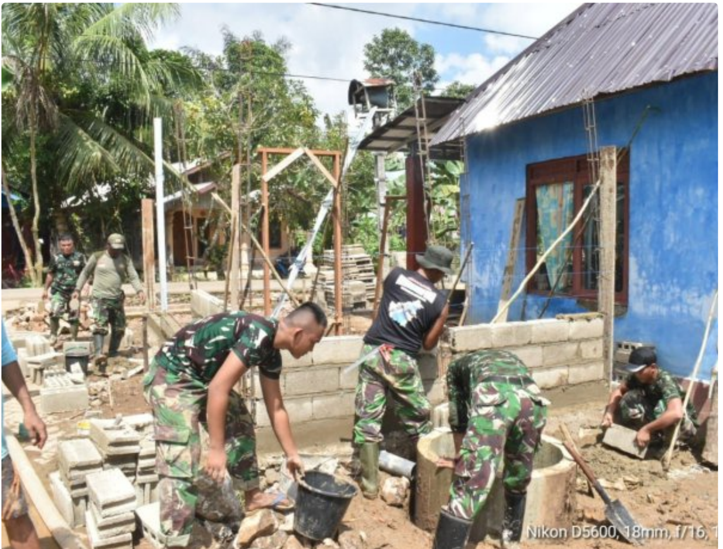
Satgas TMMMD ke-116 Kodim HST Bangun Kamar Mandi, WC dan Tempat Berwudhu Musholla Darul Iman
